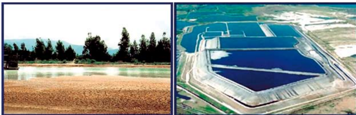
Fig. 4 - Aspecto de uma escombreira (bacia de deposição) de uma mina de urânio e de uma bacia de gesso fosfatado.
